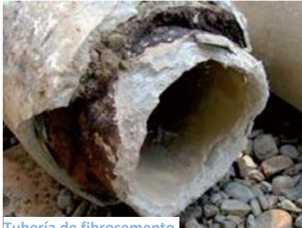
Tubería de fibrocemento
