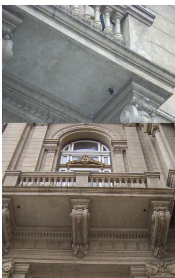
Foto 4: Reformas en el Teatro. Caños de desagüe en los balcones y grietas sobre la fachada lateral de la calle Tucumán
