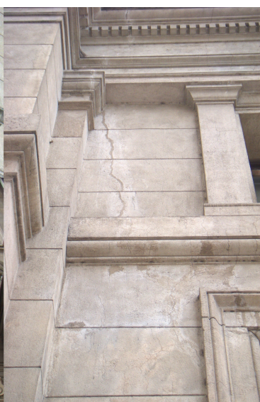
Foto 4: Reformas en el Teatro. Caños de desagüe en los balcones y grietas sobre la fachada lateral de la calle Tucumán
