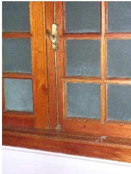
Dañaron visiblemente los sistemas de herraje de las ventanas y la estructura de madera
