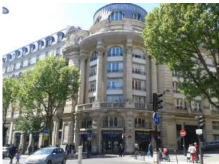
La ciudad haussmanniana y el edificio tripartito, la fachada y la esquina. Edificio Boulevard Barbès y rue Christiane.
