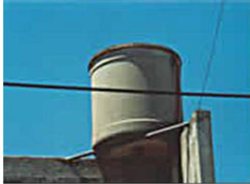
Tanque de agua de fibrocemento
