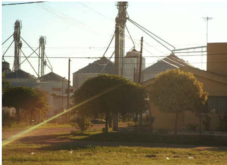
Silo en el pueblo de Monte Cristo ubicado en pleno barrio. Es un claro ejemplo de incumplimiento de la zonificación urbana. Fuente: http://www.grr.org.ar/campanapdf/fotos.php
