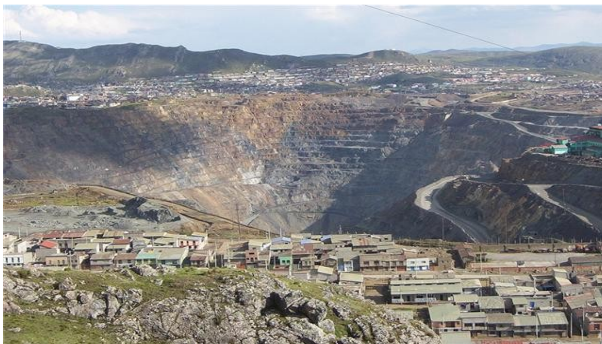
Este es el Tajo "Raúl Rojas", de Cerro de Pasco, que tiene 2 km de diámetro y 400 m de profundidad. Los tajos Tajo Perol y Chailhuagón serán mucho más profundos (660 m y 470 m, respectivamente).
