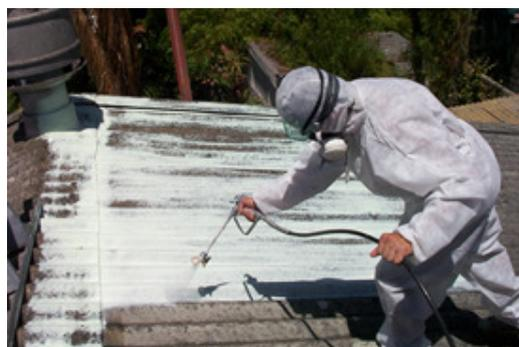
Las alternativas más usuales a la retirada del fibrocemento son el doblado de cubiertas o el encapsulado.
