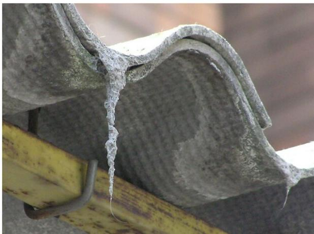
Pero lo más frecuente (un 65% de los casos) es que se presente en forma de fibrocemento, es decir en una mezcla de amianto con cemento en unas proporciones de 10-20% de amianto y el resto de cemento.
