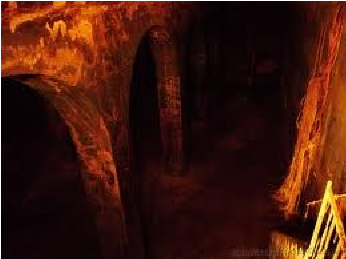
Depósito de agua
