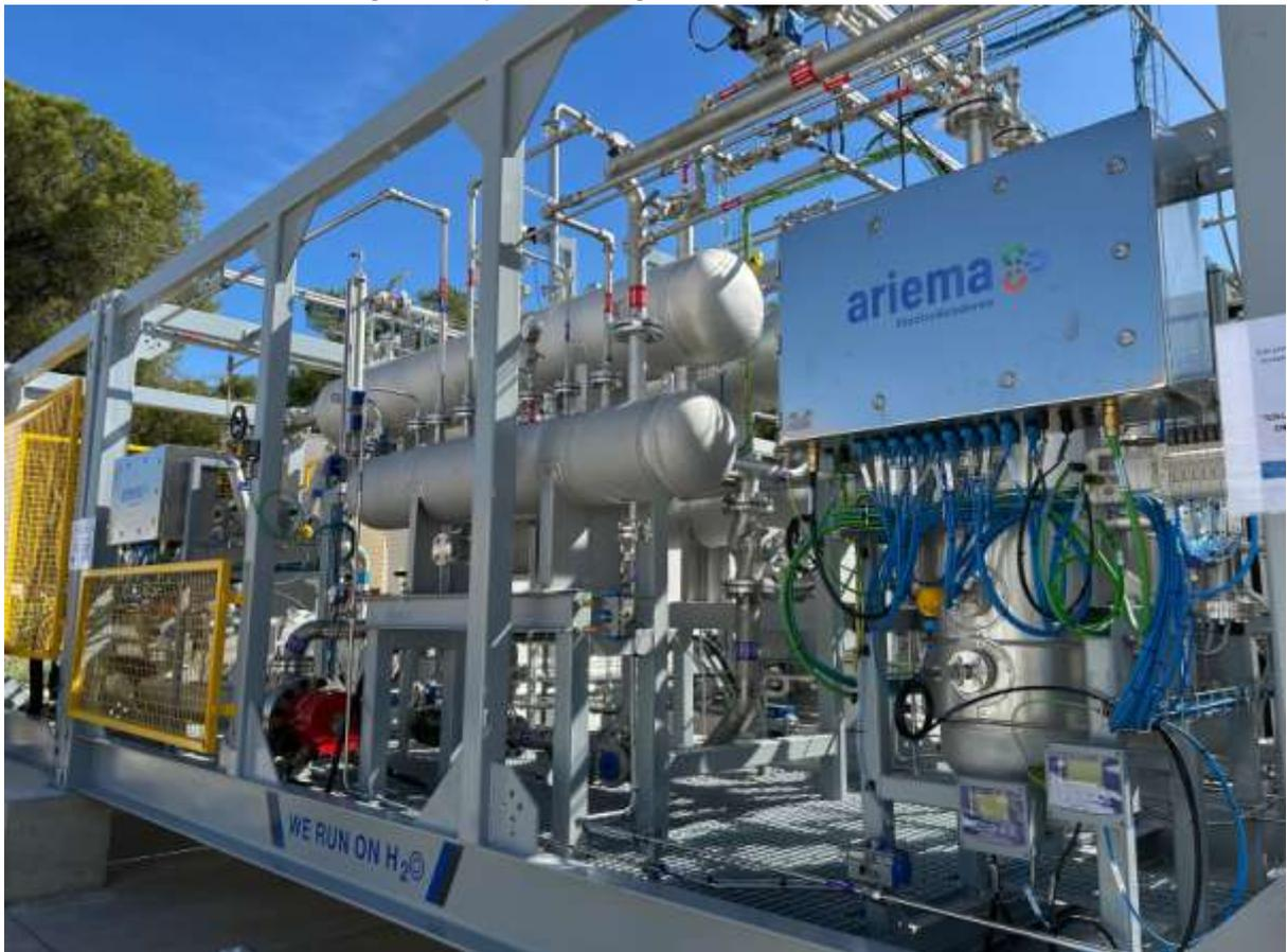
Esta planta cuenta con un electrolizador de 0,5 MW y su objetivo es, entre otros, suministrar a un generador propulsado por el novedoso motor de hidrógeno DEUTZ TCG 7.8 H2 que ha diseñado y creado la empresa con el fin de autoabastecerse de energía. De esta forma se contribuye a la descarbonización de la empresa, es decir, a la sustitución de combustibles fósiles por otros renovables.
