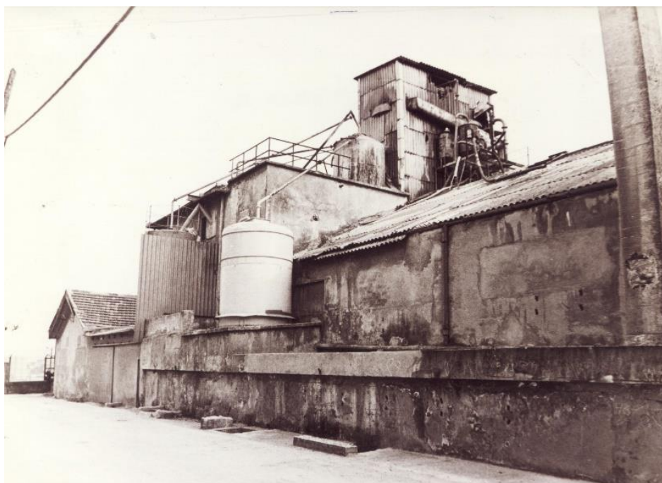
Fábrica Fibrocementos Vascos/Toschi Ibérica en Altza. Fuente www.estibaus.info
