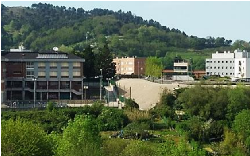
Estado actual colegio Harri Berri Oleta y parking sobre vertedero (2017)
